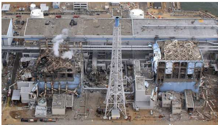
Abbildung 1: Block 3 des Kernkraftwerkes Fukushima Dai-ichi in Japan nach der Explosion (Quelle: http://de.rian.ru/society/20110406/258773128.html )
